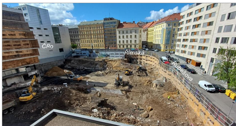
Obr. 10 Celkový pohled na stavební jámu po demolici areálu Transgas v květnu 2025.
