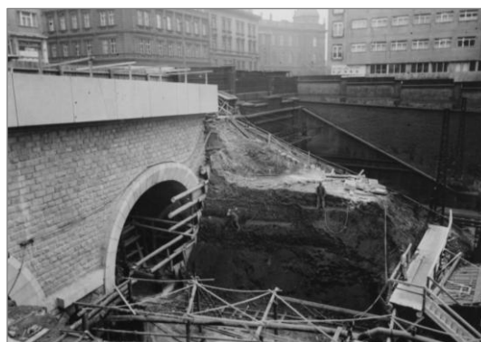
Obr. 4 Fotografie z ražby II. Vinohradského tunelu z roku 1942 zachycuje prostředí libeňských břidlic na čelbě v pase č. 122; vpravo pohled na portál tunelu z roku 1943. Zdroj: ÚSMH.
