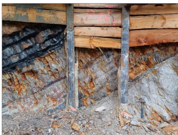
Obr. 11 Zastižené polohy řevnických křemenců s deskovitou až hrubě lavicovitou vrstevnatostí a různým stupněm rozpukání (vlevo); omezená poloha slabě zvětralých břidlic libeňského souvrství mezi masivními vrstevami křemenců (vpravo).
