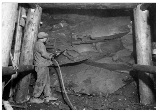
Obr. 4 Fotografie z ražby II. Vinohradského tunelu z roku 1942 zachycuje prostředí libeňských břidlic na čelbě v pase č. 122; vpravo pohled na portál tunelu z roku 1943. Zdroj: ÚSMH.
