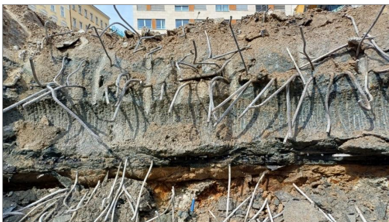
Obr. 14 Masivní železobetonová základová konstrukce bývalého Transgasu. Fig. 14 Massive reinforced-concrete foundation of the former Transgas complex.
